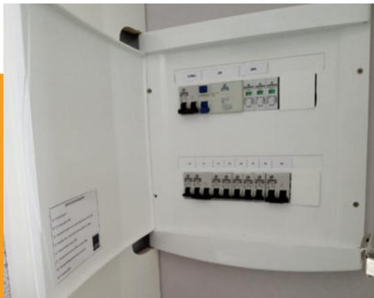
Imagem: Identificação dos disjuntores existentes no QDC dos apartamentos, instalados na área de serviço
