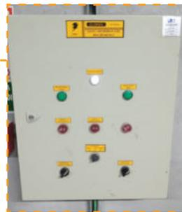
Imagem: Disjuntores identificados das bombas de incêndio
